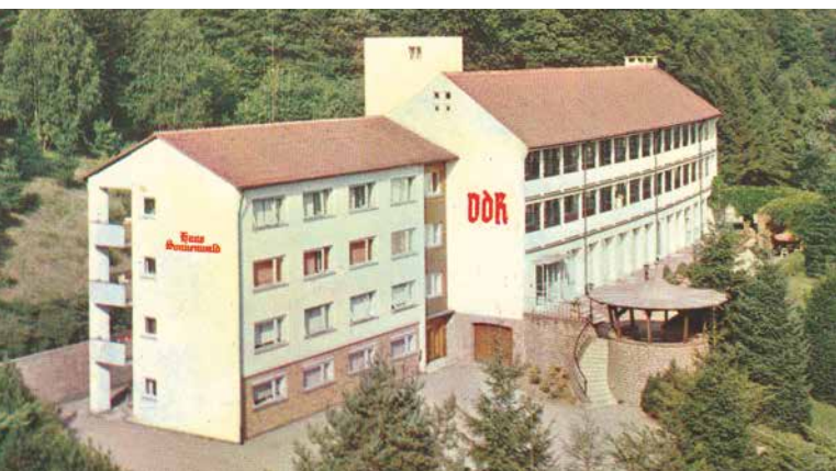
Das Erholungsheim wurde in den 60er Jahren um einen Anbau (links) erweitert.
